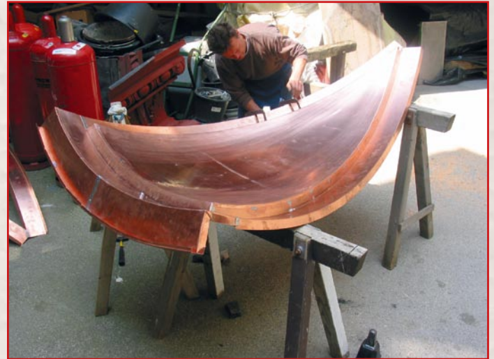
Volle Kupfernieten und Löttnähte verbinden die Dachsegmente und Gratleisten.
