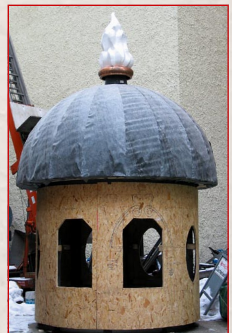
Der Holz-Rohbau lässt die Pracht der späteren Kupferlaterne nur erahnen.
