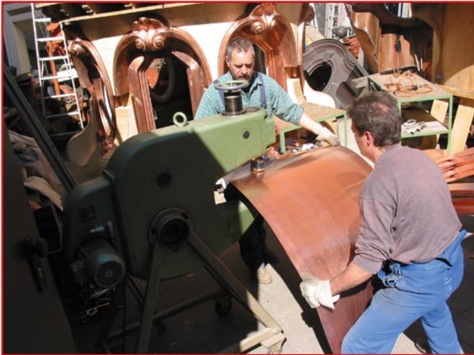
Hier wird es heiß: Die Spenglermeister Detlef Rheinwein (vorne) und Helmut Becher bearbeiten die großen kupfernen Dachsegmente.
