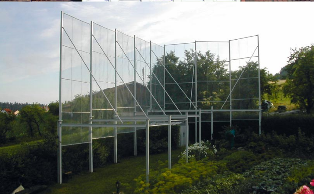
Ein Metallzaun soll die Frequenzen der dahinter liegenden Sendeanlage abschirmen. Fraglich ist, ob diese Strategie tatsächlich Wirkung zeigt. (Quelle: pixelino.de)
