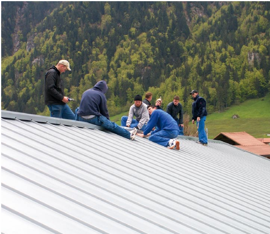
Stolze Lehrlinge bei den Abschlussarbeiten am First.
