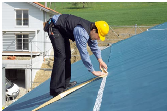
Das winddichte und regensichere Verkleben von Dach- und Fassadenbahnen erleichtert Wigluv, weil es sich beispielsweise auch für extreme Temperaturen eignet.
