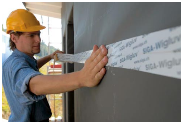
Auch für das Verkleben von Fassadenbahnen eignet sich das flexible, diffusionsoffene und wasserdichte Wigluv-Klebeband.
