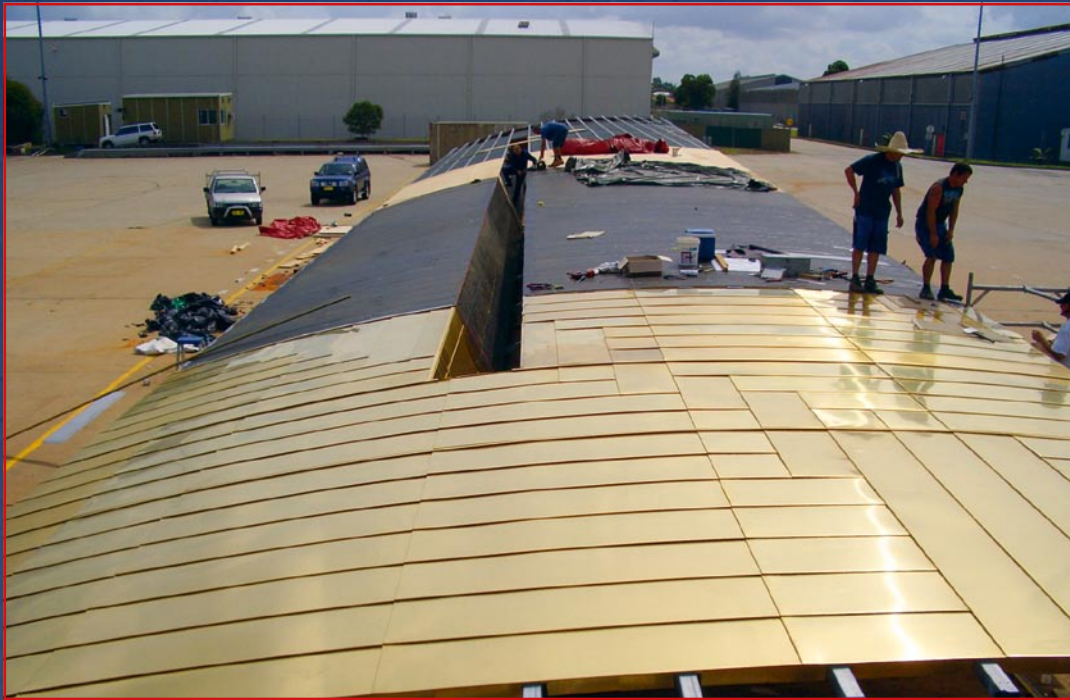
Auf einem großen Platz liegend wächst die goldene Wand. Während die unteren Fassadenelemente bereits mit den Tecu Gold-Schindeln bekleidet waren, befanden sich die weiter oben liegenden Bauteile noch im Rohbau. Auf der Unterkonstruktion aus Vierkantprofilen wurden 17 mm starke Mehrschicht-Holzplatten und selbstklebende Bitumenbahnen aufgebracht.
