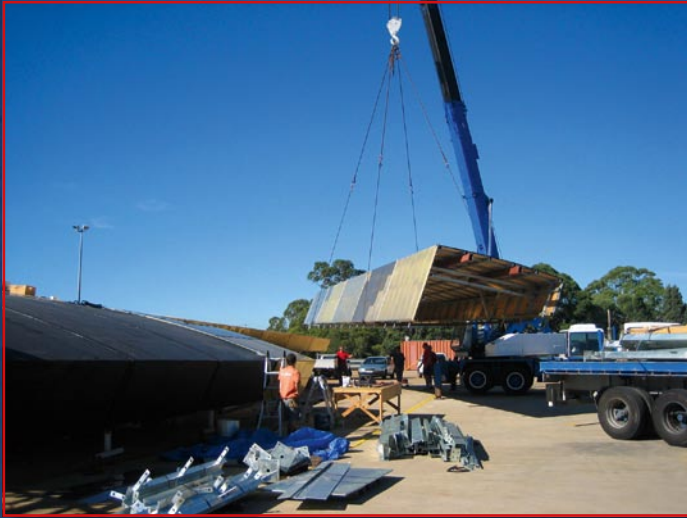
Diese Fassadenkomponenten wurden von den australischen Kollegen „Wing“, also „Flügel“, genannt. Spätestens als die riesigen Bauteile am Kranhaken hingen war klar, wie die vorgefertigten Elemente zu ihrem Namen kamen.
