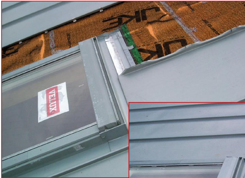
◀ Situation während der Ausführung; die obere Schar greift in den aufgelöteten Zusatzfalz des Eindeckrahmens, dahinter ist das Strukturgeflecht zu erkennen.
