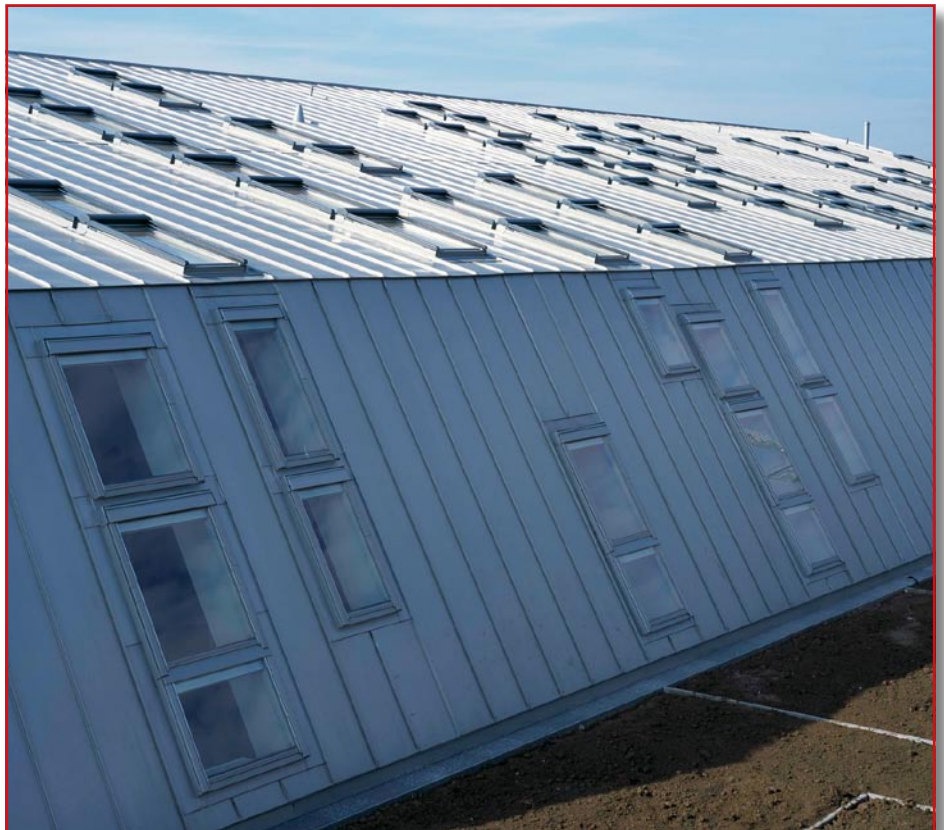
Blick auf die 60°-Schräge mit integrierten Dachflächenfenstern, die Winkelstehfalze sorgen für eine markante Gliederung des Daches.
