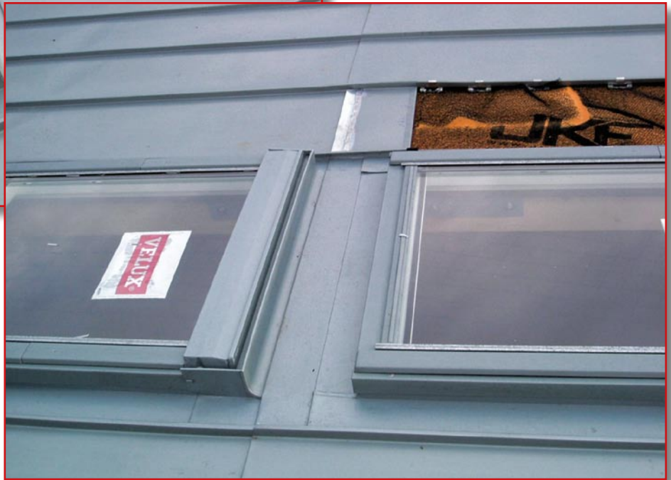
Auch die in vertikaler Reihe übereinander eingebauten Velux-Fenster wurden exakt in die Winkelstehfalzdeckung eingebunden. ▶
