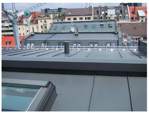
Die schönste Dachlandschaft ist nur so gut wie deren Anschlüsse. Im Vordergrund erkennbar: eine handgefertigte, großflächige Sonderverwahrung mit rundem Nackenbereich als erste Wahl für den Dachfensteranschluss.
