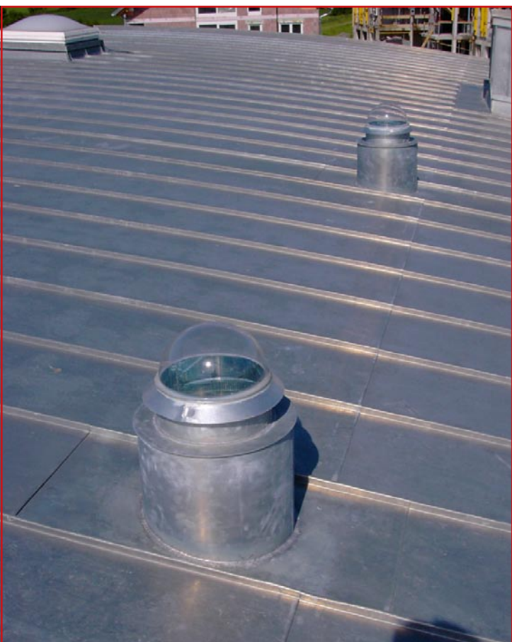
Bild 10.: Verwahrungen von Lichtleitsystemen können aufgrund ihrer geringen Größe direkt in metallische Dachflächen eingelötet oder -gefalzt werden. Anschlusssicherheit ist somit auch bei geringen Dachneigungen gegeben. ▼
