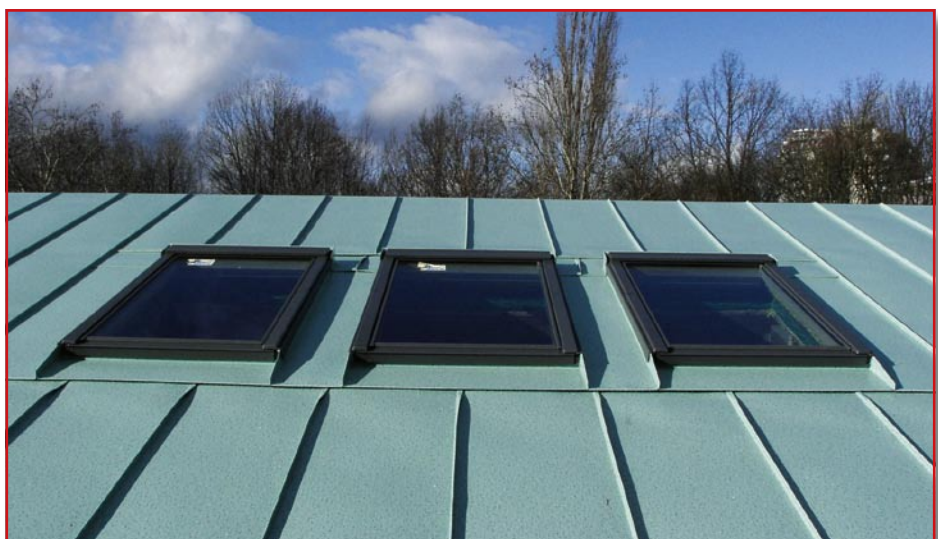
Bild 6.: Eine Möglichkeit des Anschlusses an Dachwohnfenster: Meisterliche Verwahrungen aus farbbeschichtetem Aluminium aus Klempnerhand.
