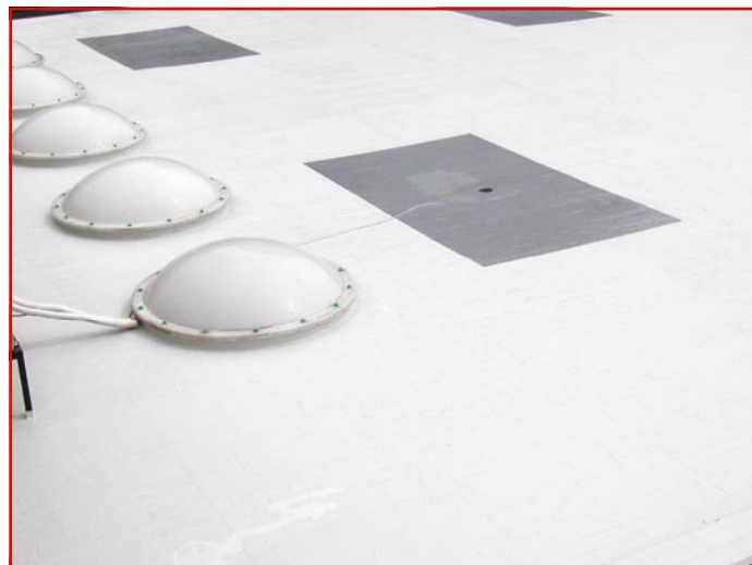
Bild 9.: Die fachmännisch ausgeführte Lichtkuppeleindichtung mit dem Enke-Flüssigkunststoff Enkopur ist eine wirtschaftlich interessante Alternative zur Metalleindeckung, besonders bei flachgeneigten Einbausituationen. (Bild: Enke)
