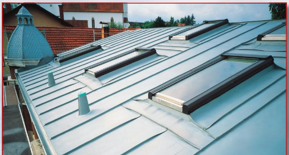
Bild 1.: Ein Falzink-Dach mit traditioneller Falzausbildung an Dachfensteranschlüssen. (Bild: Corus)
