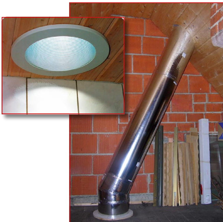
Bild 11.: Ein Lichttunnel befördert Tageslicht zur Streulinse an der Badezimmerdecke. (Bild: Talis Tageslichtsysteme)
