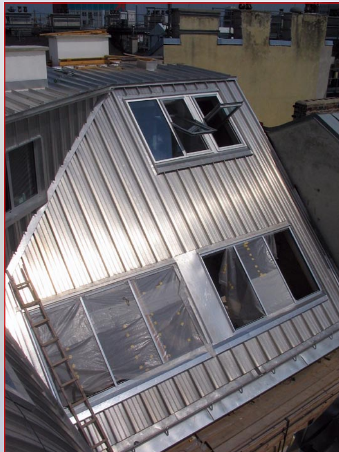
Bild 3.: Formschön, filigran und flächenbündig sind die Anschlüsse der Kal Zip-Bedachung an das Fenster- und Fassadensystem Schüco FW50+ ausgeführt. (Bild: Corus)
