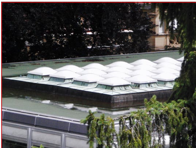
Bild 8.: Ein Lichtkuppelmeer umgeben von erstklassiger kupferner Klempnerarbeit.
