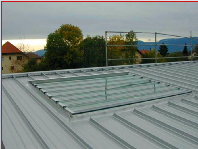
Bild 2.: Die Stebler Glashaas AG hat sich auf Lamellenverglasungen und Lamellendachfenster, die bereits ab einer Dachneigung von 7° eingesetzt werden können, spezialisiert.
