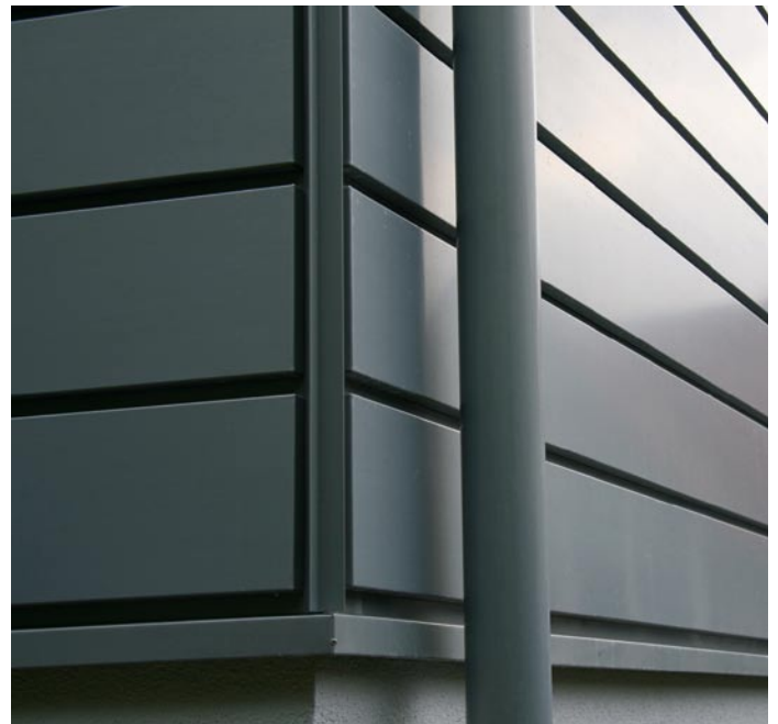
Linientreu - perfekte Ecklösung trifft Titanzinkrohr.
