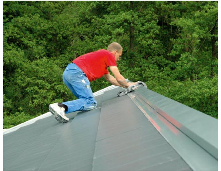
Finish – Andreas Reichert überprüft den Fassadenanschluss am Pultdachfirst.
