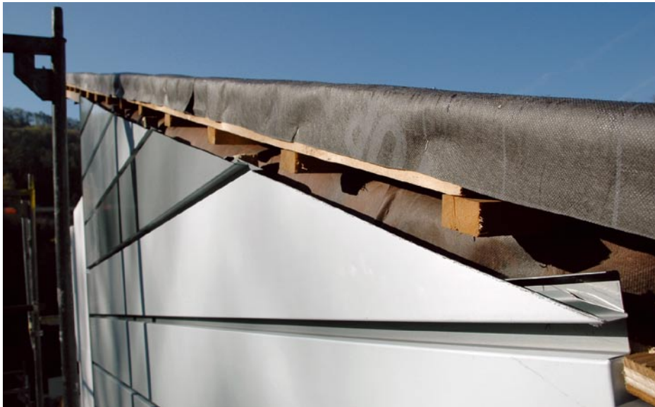
Schnittig – der Anschluss an die Pultdachfläche bietet ausreichend Platz für die Hinterlüftung
