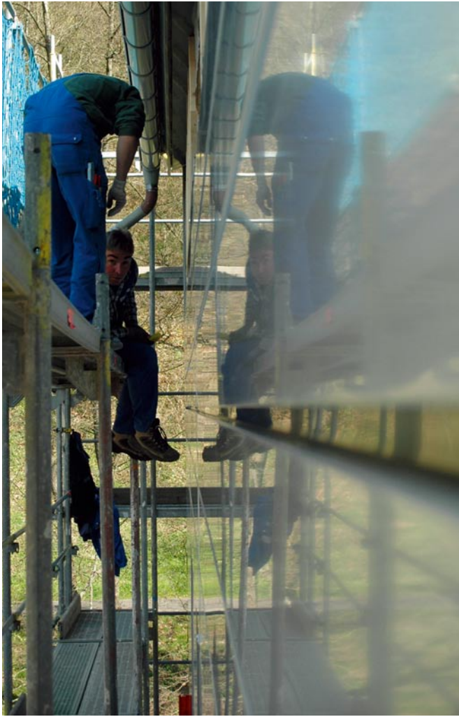
Glänzend – die Klempner Walter Maidel und Sven Dürr der Reichert GmbH, spiegeln sich auf der folierten Oberfläche der Rheinzink-Horizontalpaneel-Fassade.
