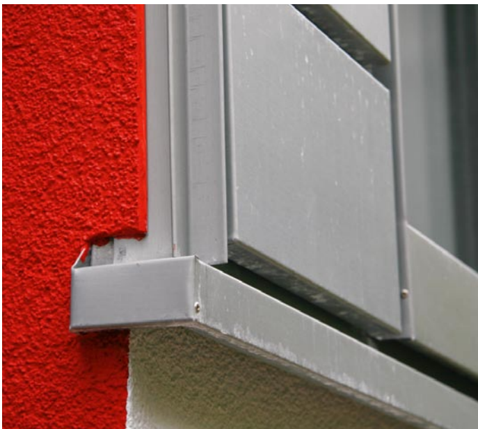
Keine Chance – M.A.S.C.-Putzanschluß-Schienen verhindern die Gefahr von Rissbildung.
