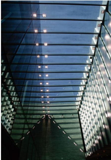
Beidseitig geben Dachfenster den Blick auf die äußere Fassade frei.
