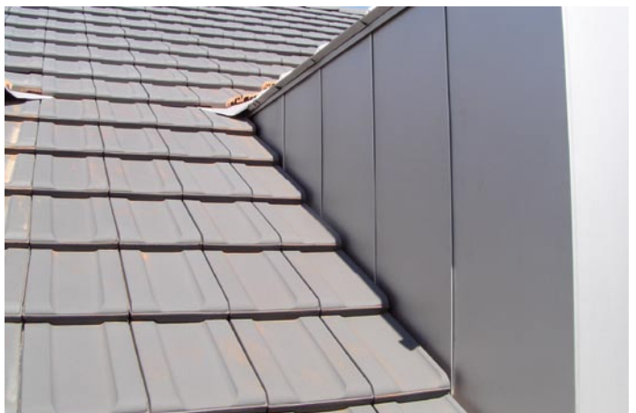
Die seitliche Gaubenbekleidung wurde durch einen 30 mm Einhangfalz verbunden.
