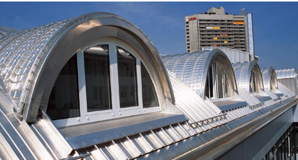
Bild 10.: Knickbombierte Profiltafeln schmiegen sich an gerundete Dachformen (Bild Corus).
