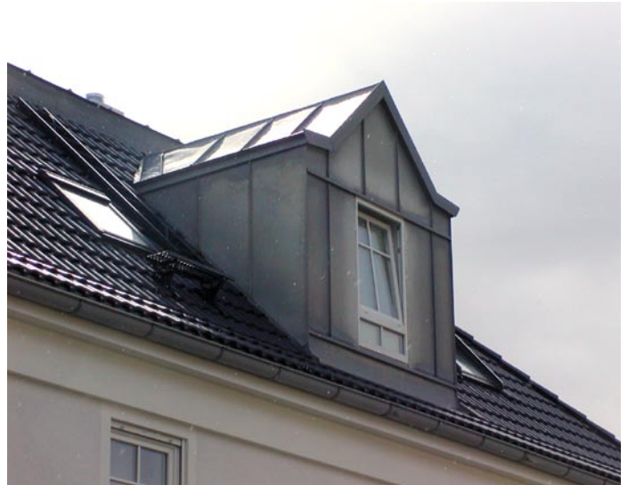
Bild 6.: Eine mit Ugitop bekleidete Gaube setzt individuelle Architekturakzente. (Bild: RCC & Weha GmbH)
