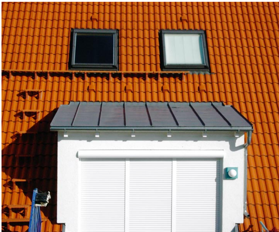
Bild 8a.: Ein Knick in der Ortganglinie und ein Schrägschnitt am Ortgangbrett ermöglichen die optimale Weiterführung der Dachdeckung. Die Unterspannbahn ist jedoch nicht optimal angebracht. Sie hätte auf dem Anschlussbereich der Schleppdachgaube verklebt werden müssen.
