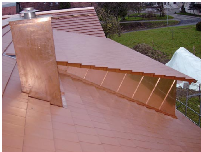
Bild 14.: Winkelrecht zur Dachfläche verlaufen die Winkelfalze dieser kupferbekleideten Dachgaube.
