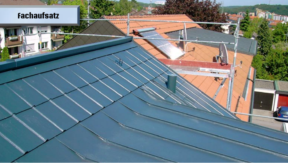
Bild 9.: Hier ist alles aus einem Guss, Aluminium-Dachplatten und -Bandmaterial von Prefa.
