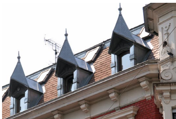
Bild 13.: Klempnerornamente aus Titanzink an einem historischen Gebäude in Bregenz.
