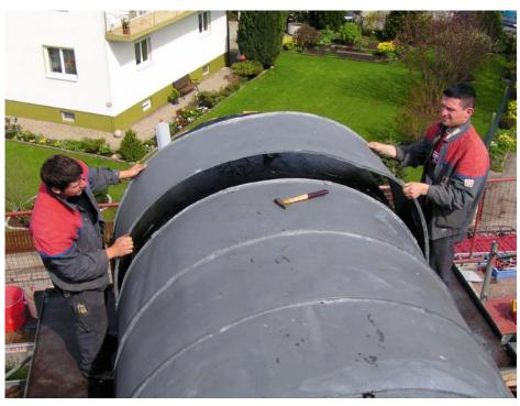
Nach dem Entfernen der Spenglerschrauben konnten die Schare einfach abgehoben werden. Hafte oder sonstige Befestigungen fehlten.
