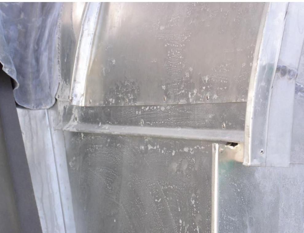
Gefalzt, genietet, drangepappt: Die Walzbleiabdeckung links erinnert fatal an einen vergessenen Putzlappen. Die Öffnung rechts im Bild sorgt stets für frisches Wasser in der Gaube und damit für lustige kleine Pilze in der Holzkonstruktion.
