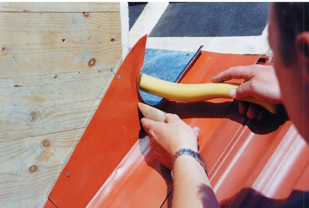
Seitliche Verwahrung eines Schornsteins. (Bild: Röhr + Stolberg GmbH)
