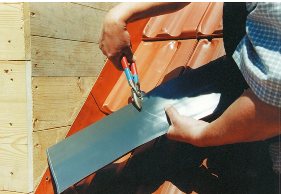
Herstellung einer Aufkantung für den firstseitigen Anschluss. (Bild: Röhr + Stolberg GmbH)
