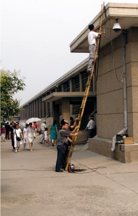
Chinesische Kollegen besteigen mit einer selbst gebastelten Bambusleiter das Dach...
