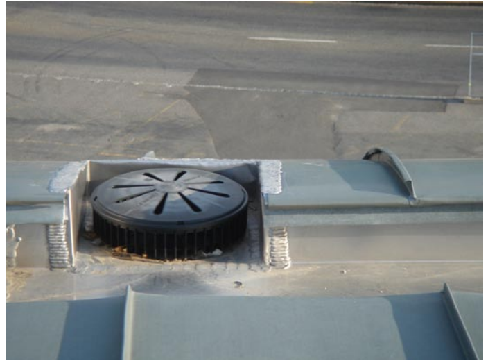
... Einlaufpunkten des Unterdruck-Dachentwässerungs-Systems.
