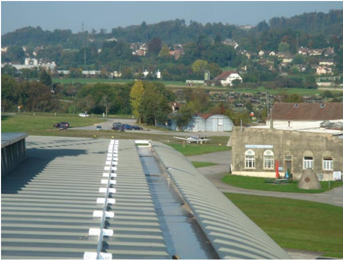
Die innen liegende Rinne mit einem Querschnitt von 770 cm 2 führt das Niederschlagswasser zu den ...
