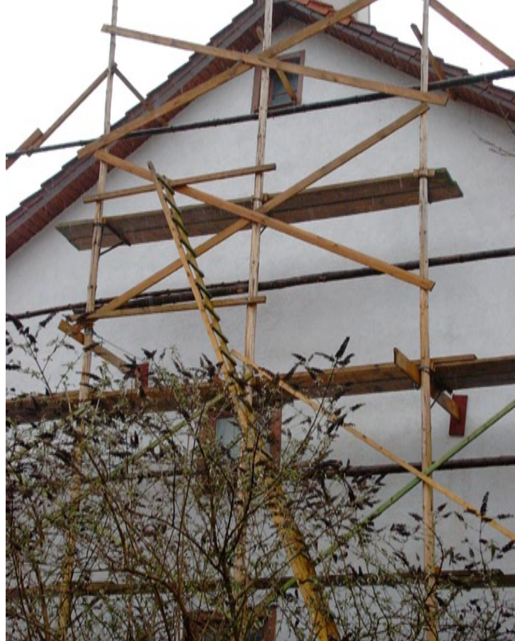
Dem Himmel etwas näher kommt man über diese aus Dachlatten gefertigte Lattleiter.
