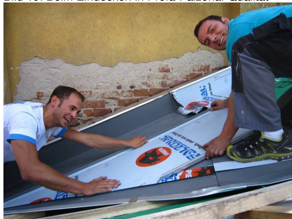
Bild 20: Seitenkehlan-schlüsse
