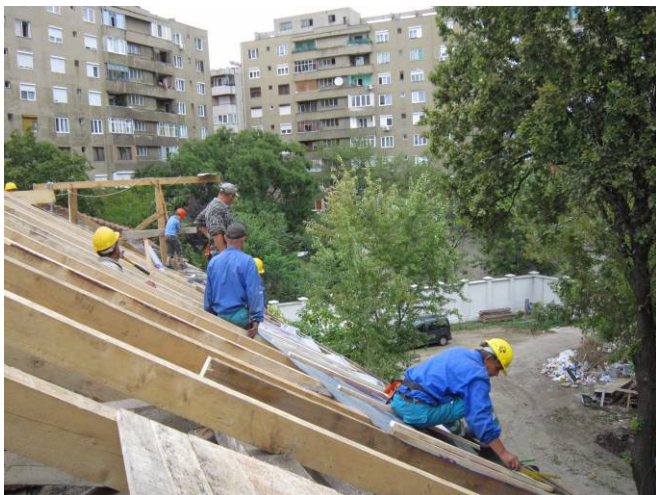
Bild 11: Wir arbeiten nicht wie rumänische Dacharbeiter – 20 m Fallhöhe ohne jegliches Gerüst
