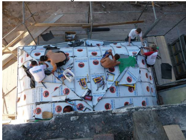
Bild 29: Eingedeckt mit Schutzfolie
