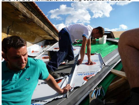
Bild 19: Beim Eindecken in Profa-Falzonal-Qualität
