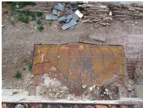
Bild 27: Das „Dach“ im Rohzustand
