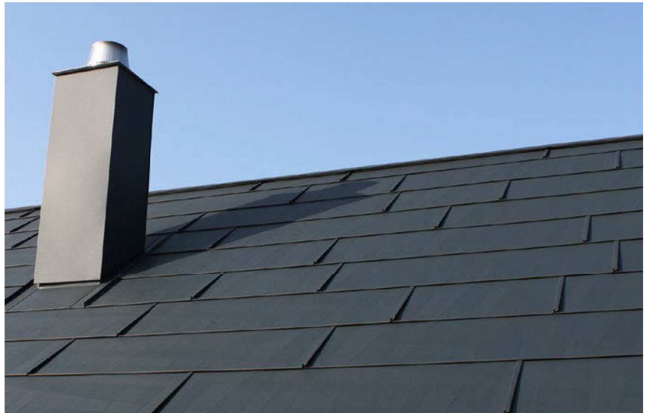
Der Schornstein wurde ebenso wie Dachfenster und weitere Durchbrüche in die Dachfläche eingefalzt – der Firstlüfter ist eine Sonderlösung
