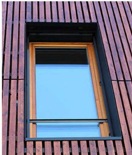
Die Laibungsprofile aus Prefa-Aluminium in P.10-Qualität – hier an der Holzfassade sowie an den Fensterlaibungen und Sims
