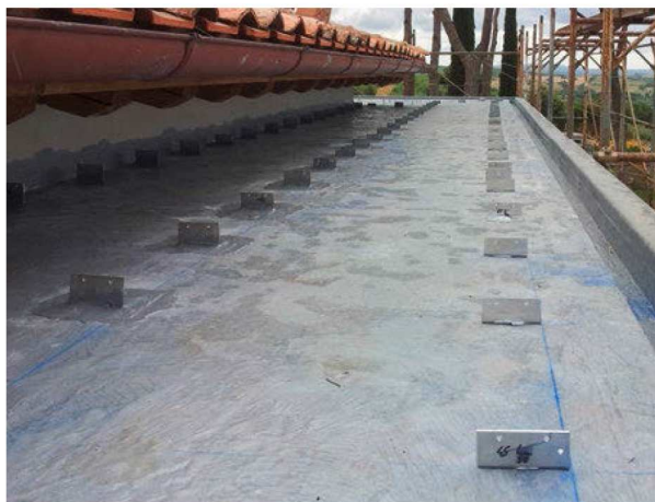
Enkopur-Flüssigkunststoff dichtet Konsolen sicher ab
