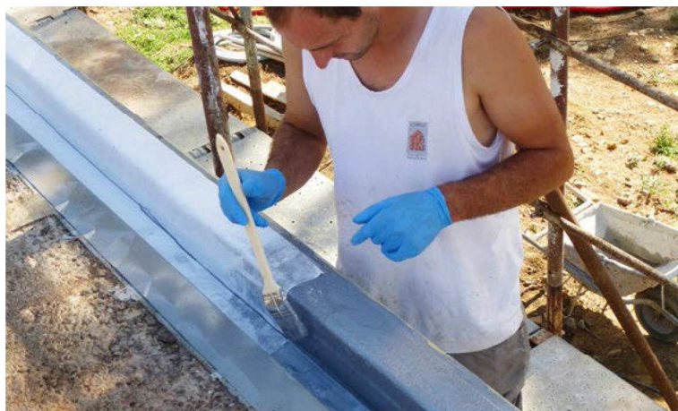
Die Abdichtung des Dachrandes erfolgte ebenfalls mit Flüssigkunststoff
